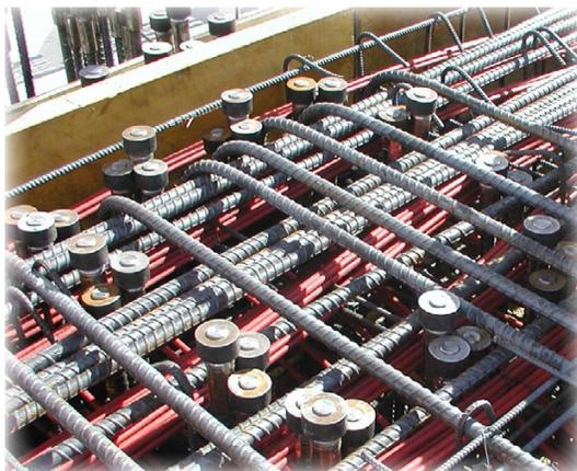
**L'ANCRAGE MÉCANIQUE** se fait facilement et rapidement à l'aide du GRIP-TWIST DoughNUT™ à filetage conique. Les problèmes d'encombrement créés par l'utilisation de barres à crochets sont évités.
